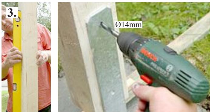
Das Holzprodukt aufstellen. Die Pfosten in die H-Pfostenanker stellen. Etwas Abstand zwischen Pfostenende und Metall lassen. Die Pfosten durchbohren um sie mit den H-Pfostenankern zu verschrauben.
