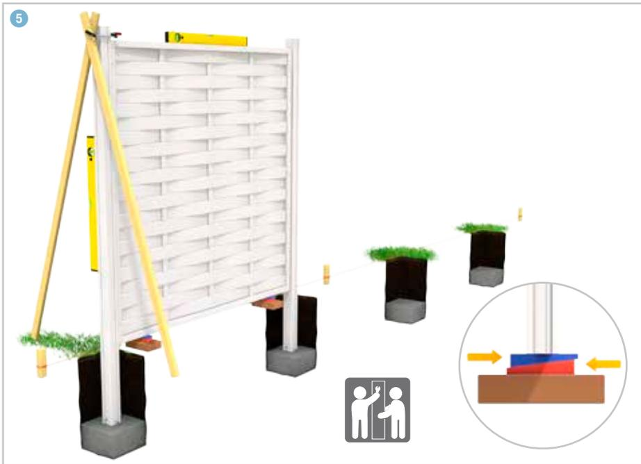
5 Schnur in Bodenhöhe setzen und stark spannen. Mit Klebestreifen die genauen Pfostenabstände an der Schnur markieren.
