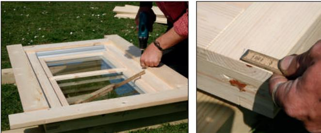
Die Fenster- und Türelemente werden fertig vormontiert geliefert. Vor dem Einbau müssen jedoch noch die äußeren Rahmenleisten aufgeschraubt werden, die den Rahmenelementen an der Wand den Halt geben.
