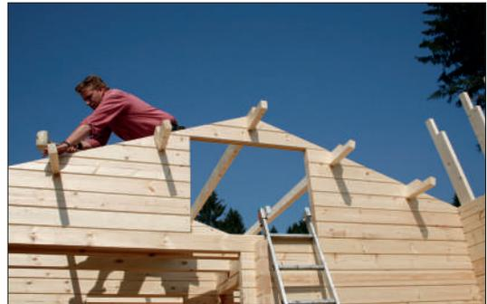
Die Balken werden einmal in der Länge „gestoßen“. Das heißt, ein besonderer Einschnitt, (siehe Abb.) ermöglicht eine Längsverbindung ...
