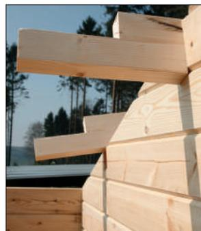
... durch Verschraubung. Eine weitere Befestigung der Balken ist nicht erforderlich, da die später aufgebrachte Dachschalung für genügend Halt der Konstruktion sorgen wird.
