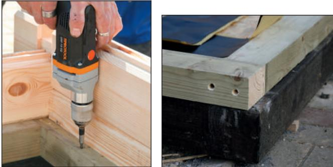
Zwischen Grundplatte und Bodenbalken kann eine Bitumenrollbahn ausgelegt werden.
