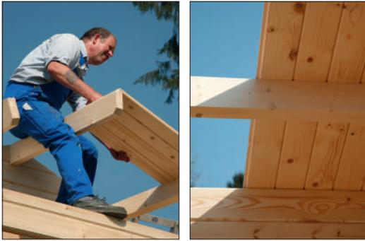
Achten Sie hier beim Verlegen auf einen gleichmäßigen seitlichen Überstand. Notfalls wird ein seitlicher durchgehender Versäuberungsschnitt nötig.
