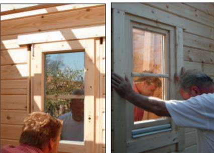
Nun wird von einem Helfer das Fenster von außen in die Öffnung gedrückt. Von der Innenseite können nun auch die Rahmenleisten geschraubt werden. Das Fenster sitzt. **Achtung:** Die Fenster und Türen sollen nie direkt mit den Wänden verschraubt werden. Das Holz muss arbeiten können.
