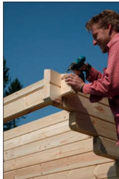
Einzelne Giebelbohlen der Nummerierung entsprechend aufsetzen und von oben in das untere Profil verschrauben.
