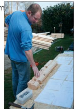
Beiliegende Zeichenpläne definieren jedes Bauteil an seinem Platz mit einer Nummer, die Sie auf den einzelnen Bohle wieder finden werden.
