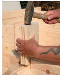
Die Wandprofile für die Tür- und Fensteröffnungen weisen an den nach innen stehenden Enden sog. Kopfnuten auf. Diese spielen später beim Einbau der Fenster und Türen eine besondere Rolle.
