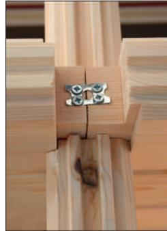
Bei den längsten Wandprofilen kann es im Einzelfall vorkommen, dass das Profil in der Länge gestoßen wird. Hierfür verwenden Sie beiliegende Schraubklammern. Die Verbindung erfolgt immer (unsichtbar) in der Eckverbindung.
