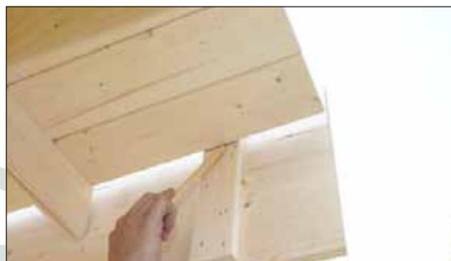
Die erste Seitenblende wird angehalten. Am höchsten Dachpunkt etwa 8-10 cm oberhalb der Dachoberfläche, Vorderkante Blende bündig mit Vorderkante Dachfläche, waagrecht ausrichten.
