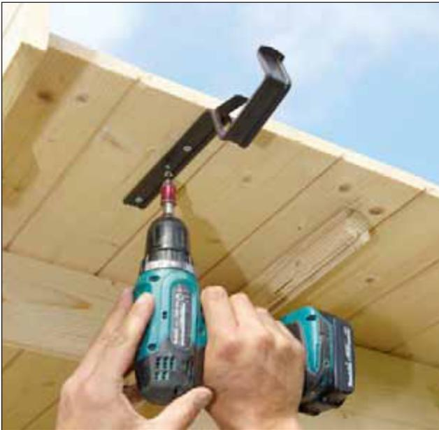
Als nächstes werden die Rinnenhaken an der hinteren Dachkante des Hauses angebracht und gleichmäßig auf die gesamte Länge des Daches verteilt. Am besten arbeitet man hier mit einer Spannschnur.
