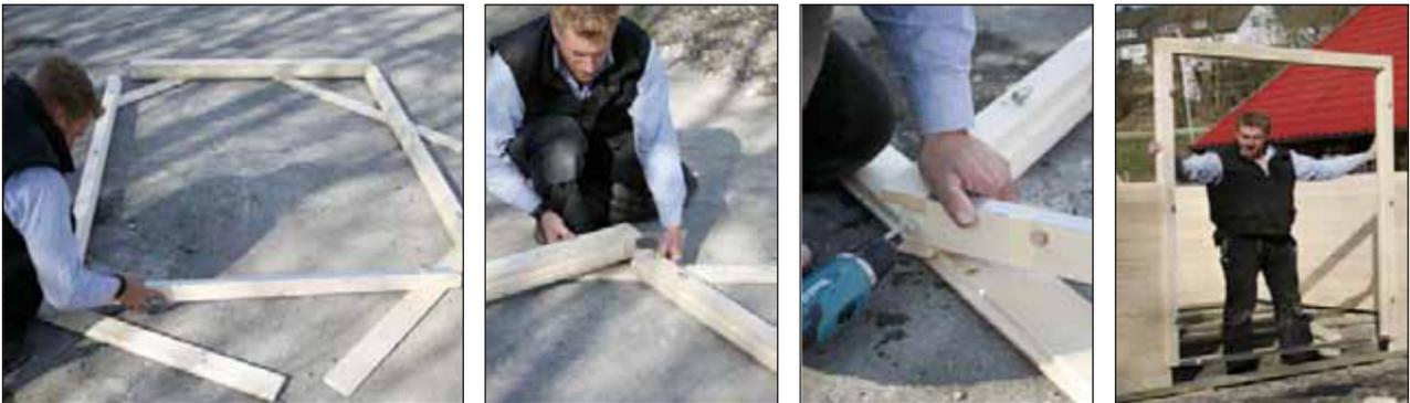
Der so zusammengesetzte Türrahmen wird von oben auf die halb aufgebaute Wand geschoben, und nicht mit den Wänden verschraubt. Abb. ganz rechts
