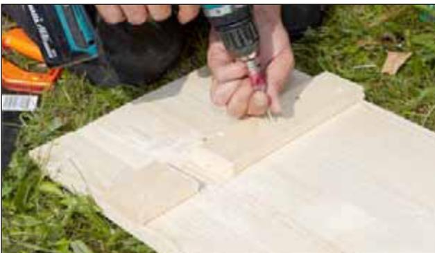
Eventuell kann es erforderlich werden, die ein oder andere Schraube zu versetzen, bzw. den Querriegel an der ein oder anderen Stelle nach zu schrauben, um die gesamte Blende zusätzlich zu stabilisieren.
