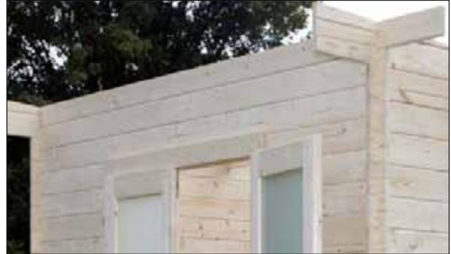
Mit dem Aufbau der letzten Wandbohlen werden auch die mittleren, querlaufenden Dachbalken eingesetzt. Wenn Sie alles richtig gemacht haben, erhalten Sie ein Montagebild wie auf der Abb unten.
