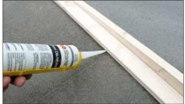
Die Fugen sollten mit Silikon (nicht im Lieferumfang enthalten) gedichtet werden. Die Dacheindeckung ist fertig.
