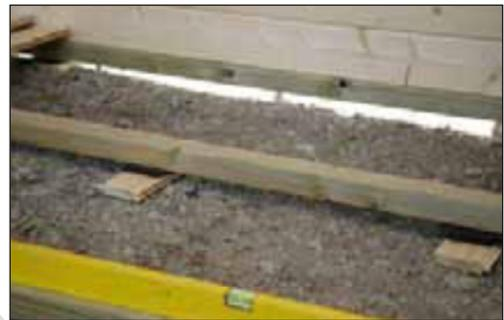
Nun kann der Bodenbelag genagelt oder verschraubt werden. Im Bereich des Türdurchgangs achten Sie auf einen sauberen Anschluss an die Edelstahlschiene, da an dieser Stelle keine Fussleisten vorgesehen sind. Evtl. kann es erforderlich werden, das letzte Brett in der Breite etwas an zu passen. Siehe Abb. unten
