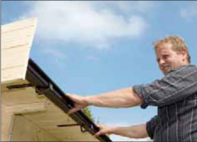
In die montierten Haken wird nun die Rinne eingelegt und durch Herunterdrücken der noch nach oben stehenden Haltetaschen fixiert. Mit den Verbindungsmuffen, Ablaufstutzen, Fallrohr und entsprechendem Zubehör kann nun das Wasser abgeleitet werden.
