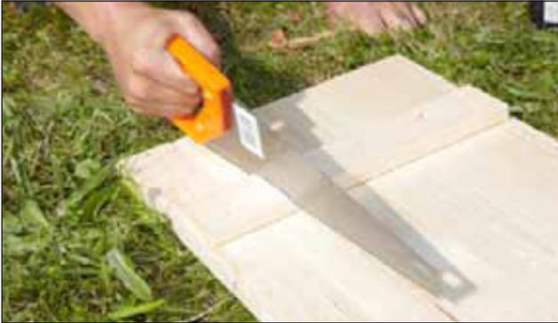
Die Querriegel werden an diesen Stellen mit einer Handsäge komplett durchtrennt.
