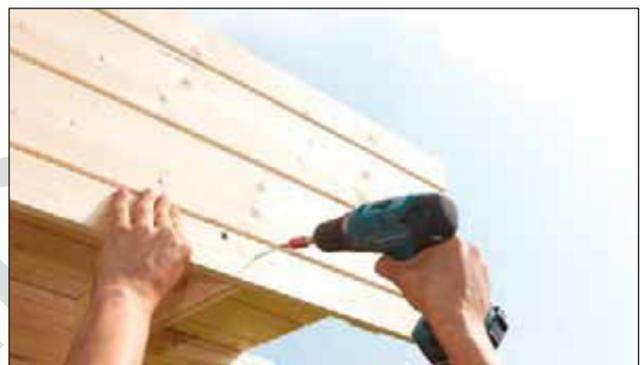
Auch die Blende an der Vorderseite des Hauses braucht die gleichen Riegelein-schnitte. Hier werden bei gleicher Vorgehensweise die Riegel alle auf gleicher Höhe unterbrochen. Die Schnitthöhen ergeben sich durch das Anhalten der Vorderblende an den schon montierten Seitenblenden.
