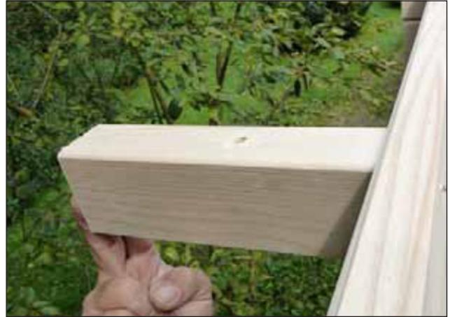
Abschließend muss noch die hintere Blende montiert werden. Da diese Blende nur Halt an den hinteren Enden der beiden Seitenblenden findet, wird nun in der Mitte der Hausrückwand eine Strebe geschraubt, die als Verbindung zwischen Hausrückwand und der Blendeninnenseite zusätzliche Stabilität gibt.
