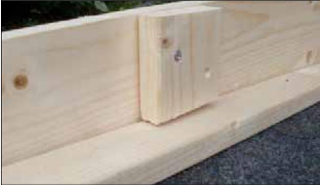
Da im vorherigen Schritt die Querriegel der Blenden etwa 5 cm unterbrochen wurden, kann nun auch die innenliegende Dachabschlussleiste gegen die Blende geschoben und dort verschraubt werden
