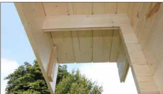
Durch die unterbrochenen Querriegel können nun die seitlichen Dachblenden direkt an der Dachkante anliegen und an den Dachbalkenenden verschraubt werden.
