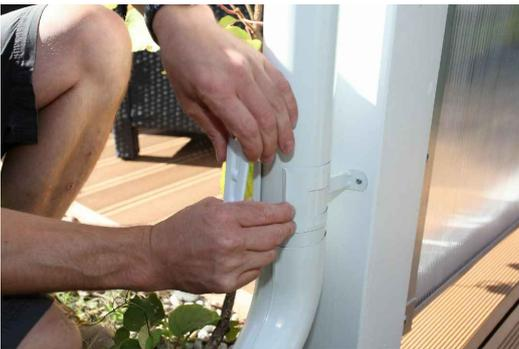
Schneiden Sie das Ablaufrohr (C165-200-01/02) auf die benötigte Länge zu und stecken Sie dieses mit dem unteren Auslauf (C168-01/02) zusammen, achten Sie darauf, dass die Naht jeweils nach vorne zeigt.
