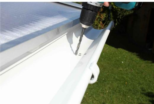
Bohren Sie an dem gewünschten Ende der Halbrundrinne (C160-Längen) ca. 15 Löcher (Ø 9 mm) für den Wasserablauf. Anschließend legen Sie die Halbrundrinnen zusammen mit dem Rinnenablaufstutzen (C164-01/02) in die Rinnenhalter. Nach dem Einhängen müssen ggf. die Ränder der Rinnen nachgebogen werden.
