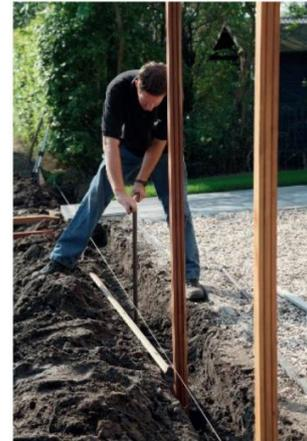
**3** Platzieren Sie die Pfosten in einem Abstand von ca. 125 cm (maximal 130 cm).
