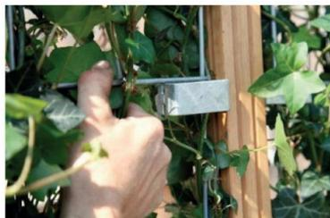
**8** Die Hecke kann in die Aussparung der oberen Halterungen „eingehängt“ werden.
