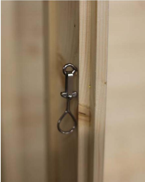
2.) Flügel anlehnen, Ermittlung Position Rahmenteil, 2mm vorbohren, anschrauben,
