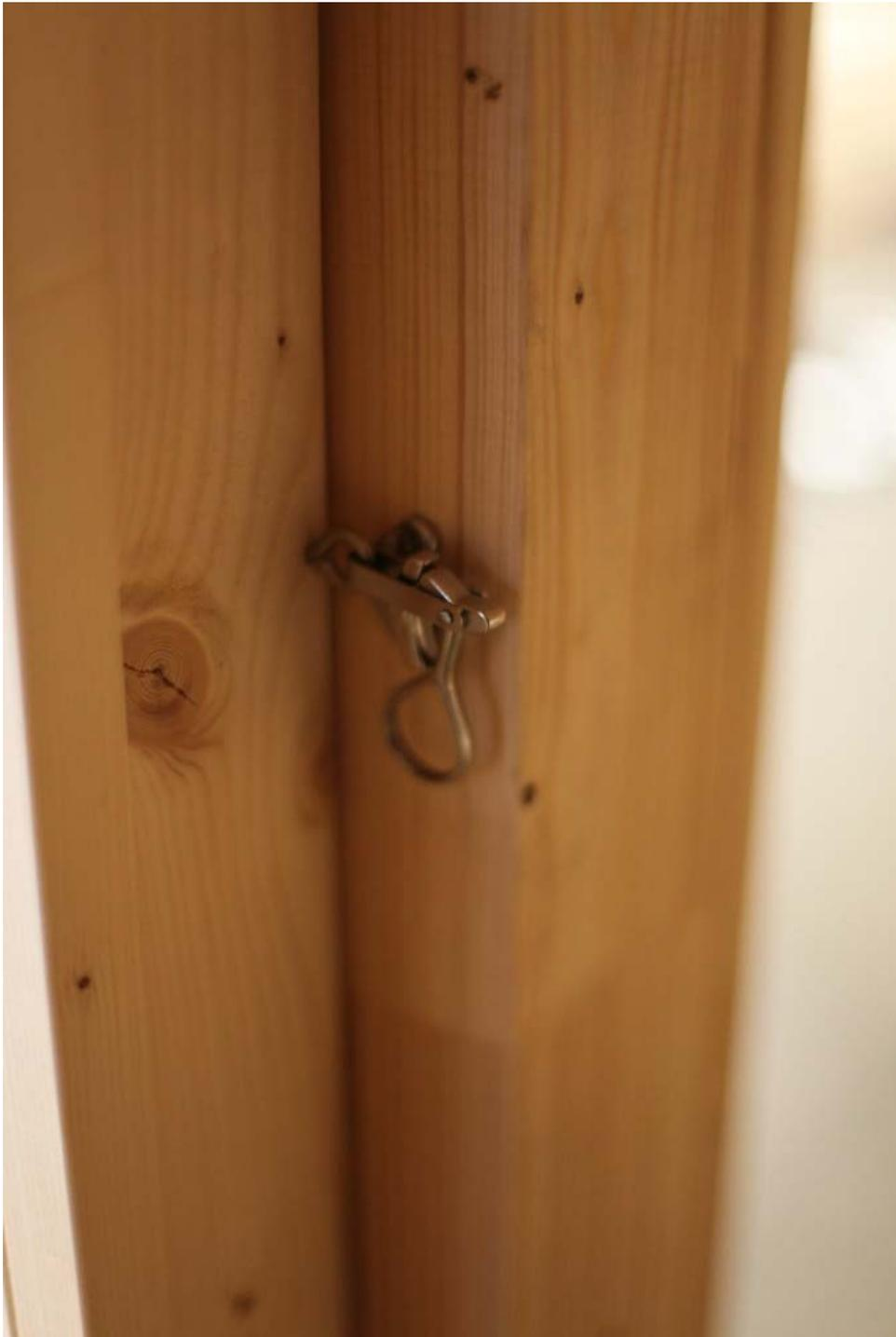
TIP: Durch Versetzen des Rahmenteils bzw. durch hinein- bzw. herausschrauben des Flügelteils lässt sich der Anpressdruck des Flügels verändern.
