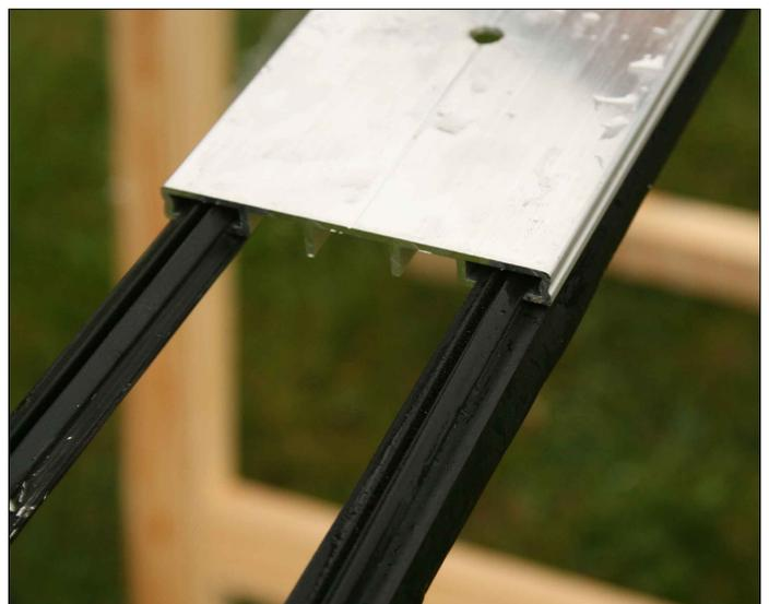
Dichtgummi in die Aluprofile einziehen.
