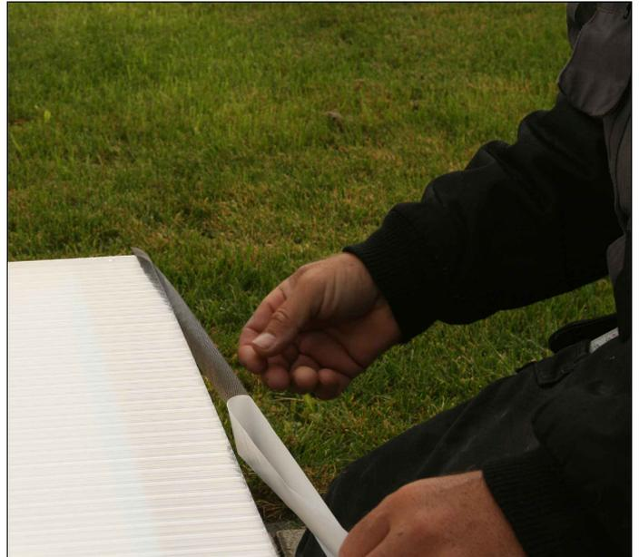
Die Doppelstegplatten von der Schutzfolie befreien (Achtung Oberseite beachten!) sowie im vorderen und hinteren Bereich mit Dichtband versehen.
