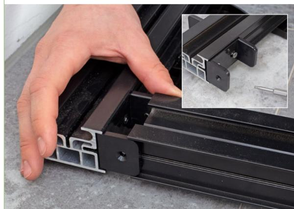
**1a** Anschließend werden die 300 mm langen Querstreben mit Hilfe der Profilverbinder mit der Alu-UK verbunden, sodass eine stabile Rahmenkonstruktion entsteht. Zusätzlich werden die Querstreben innerhalb des Rahmens alle 1,5 m verlegt.
