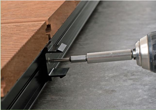
5| Zur Montage der Frontblenden dienen die Blendenclips, die alle 500 mm mit den mitgelieferten Schrauben befestigt werden.
