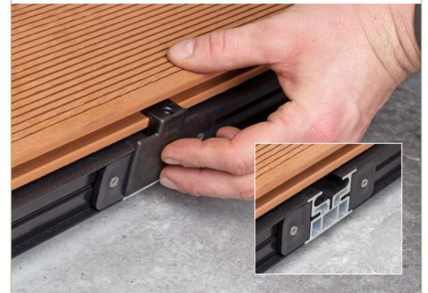
**2** Bevor die Dielen verlegt werden, müssen die Endklemmen angebracht werden. Hier wird die erste Diele eingeschoben und mit Schrauben befestigt.
