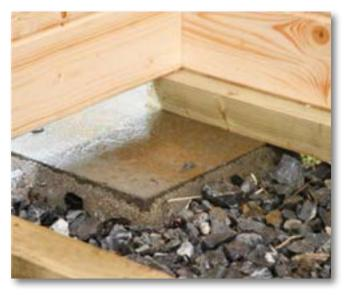
**Verdichtetes Schotterbett mit Gehwegplatten** als Minimaluntergrund für die Errichtung eines Hauses.
