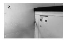
2. Außenkante des Wandanschlussprofils beid seitig auf Montageuntergrund anzeichnen. Aufstockelement vom Lichtschacht nehmen und Wandanschlussprofile vom Aufstockelement entfernen. Beim Einsatz von lediglich einem begehbaren fixen Aufstockelement kann auf die Wandverschraubung verzichtet werden.
