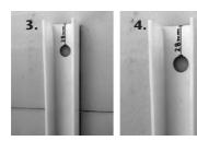
3.+4. Wandanschlussprofil in Lichtschacht-Rostauflage stellen und entsprechend der angezeichneten Markierung ausrichten. Auf richtige Positionierung der Befestigungspunkte achten. Die Befestigungspunkte anzeichnen.
