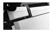
Denn Bereich unterhalb der Kennzeichnung mit einer Eisensäge oder einer anderen geeigneten Säge abtrennen. Hierbei die Schnittführung nutzen.
