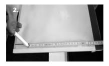
Ermitteltes Maß auf die Außenseite des höhenverstellbaren Aufstockelementes übertragen. Ausgehend von der Oberkante des höhenverstellbaren Aufstockelementes. (Dieser Punkt entfällt bei der Montage vom höhenverstellbaren Aufstockelement auf ein fixes Aufstockelement.)
