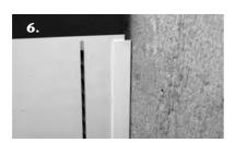
6. Wandanschlussprofil gegen Wand schieben und Rost einlegen.
