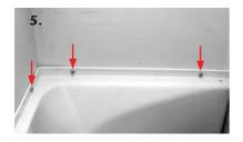
5. Das höhenverstellbare Aufstockelement über den Lichtschacht oder das fixe Aufstockelement schieben und ausrichten. Im Anschluss die Verschraubung von innen nach außen, beginnend mit den beiden hinteren Verschraubungspunkte, vornehmen.
