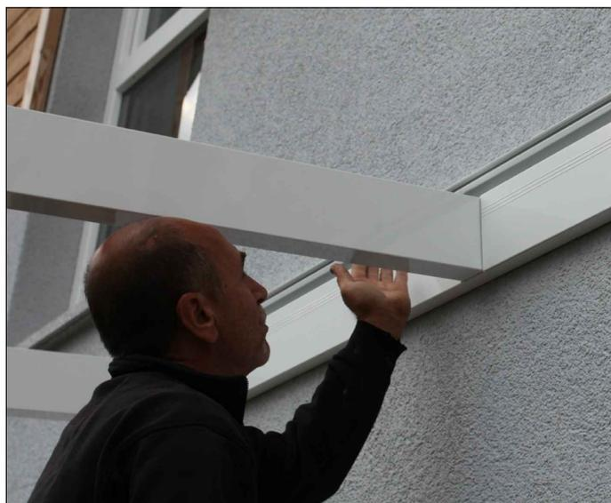
Répartissez les autres chevrons à l'aide des baguettes de recouvrement (servant d'entretoises), pré-percez les trous de vissage à l'aide d'un foret à métaux 4 mm, puis vissez les chevrons sur les deux pannes en utilisant pour chacune une vis à tôle à tête hexagonale (C101-025).
