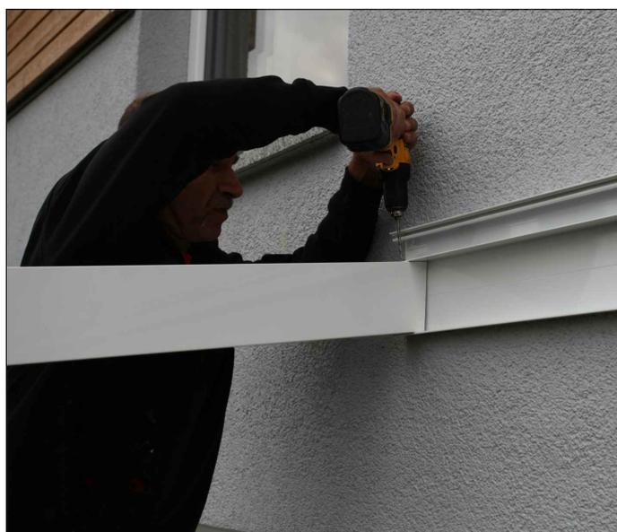
Pré-percez les trous de vissage à l'aide d'un foret à métaux 4 mm, puis vissez les chevrons sur les deux pannes en utilisant pour chacune une vis à tôle à tête hexagonale (C101-025).
