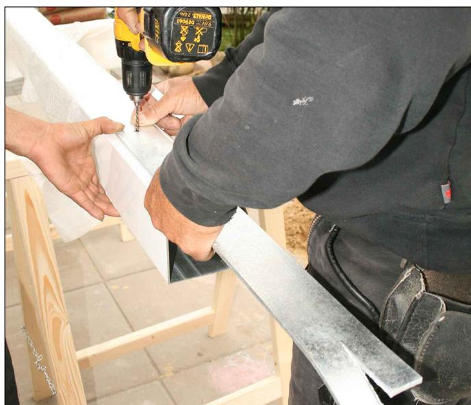
Vissez les ancrs à l'aide des vis d'assemblage filet (C115-020).
