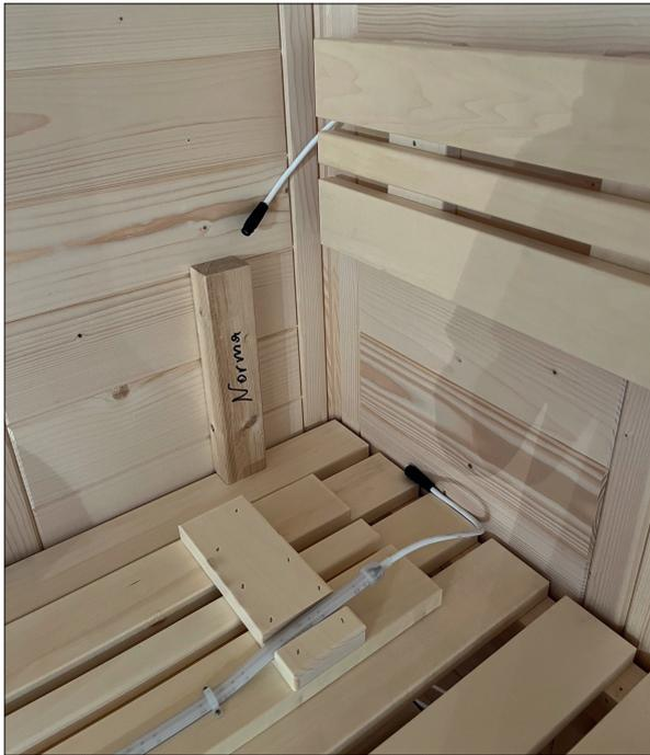
In der Ecke der Kabine muss nicht nach außen gebohrt werden, da das LED-Band direkt an das LED-Band der nächsten Rückenlehne angeschlossen werden kann.
