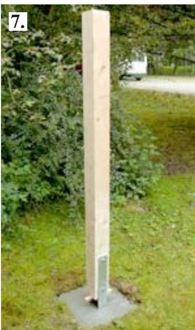
Fertig einbetonierter Pfosten.
