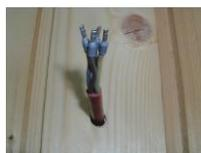
1. Wärmebeständige Signalleitung für den Fühler durch die vorgesehene Leitungsdurchführung und durch die Bohrung der Befestigungsplatte führen.
