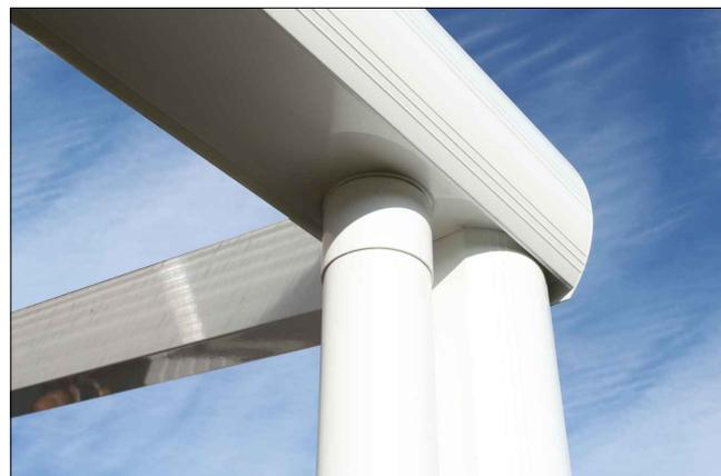
Avant de procéder au montage, posez une corde continue en silicone sur le raccord de la face inférieure. La fixation une fois réalisée, retirez le matériel excédentaire.
