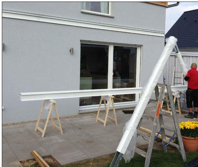
Préparez au montage la panne pour gouttière et les poteaux avec leurs ancres.
