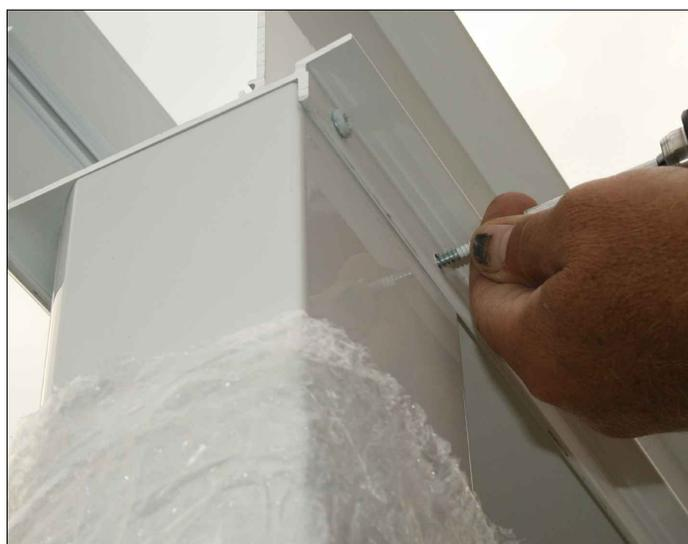
Placez la gouttière et les poteaux les uns à côté des autres en respectant cette distance, pré-percez en utilisant un foret à métaux 4 mm, puis vissez les éléments de construction en utilisant respectivement 2 vis à tête hexagonale (C101-025).
