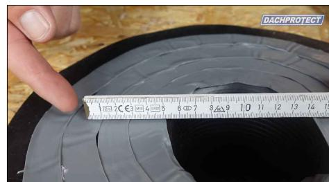
**DE** Ermitteln Sie die Mitte vom EPDM-Gully und Bohren Sie das passende Loch Ø 75mm. Verteilen Sie auf dem Stück etwas von dem Flächenkleber und kleben den Gully fest. Nehmen Sie nun das Doppelseitige Dichtband zur Hand und halten Sie sich an die Bildbeschreibung.
