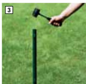
Überprüfen Sie während des Einschlagens regelmäßig die Position der Einschlagbodenhülse mit einer Wasserwaage und korrigieren Sie sie. Einfach einen Zaunpfosten aufstecken und diesen ausrichten. Die Bodenhülsen dann in voller Länge einschlagen. Sind alle Bodenhülsen eingeschlagen, können Sie anschließend die Zaunpfosten setzen. Die Pfosten werden mit einem Gummi- oder Holzhammer in die Bodenhülsen eingeschlagen. Bitte vorher die Kunststoffkappe vom Rohrende entfernen.
