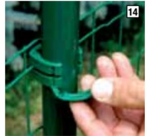
***Tipp: Um eine höhere Geflechtspannung zu erzielen, nutzen Sie den Spannkamm. Einfach durch eine Masche im Geflecht stecken und horizontal um den Pfosten herum hebeln.***
