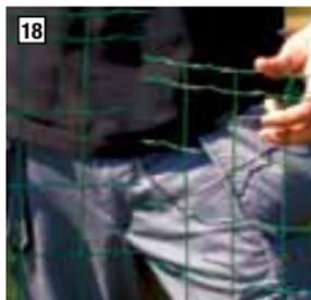
Wenn Sie 2 Geflechttrollen im Zaunverlauf miteinander verbinden bzw. verlängern möchten, dann trennen Sie jeweils den äußersten senkrechten Draht an beiden Rollen mit einem Seitenschneider heraus, so dass die horizontalen Drähte um eine Maschenbreite überstehen.
