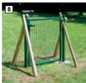
An jedem Torpfosten wird rechts und links eine Stütze, zum Beispiel Dachlatten mit Schraubzwingen, provisorisch angebracht. Den Torflügel dann mit Steinen oder Holzklötzchen unterfüttern und waagrecht ausrichten. Danach das Tor senkrecht ausrichten, indem die Stützen verstellt und mit Schraubzwingen festgezogen werden.
