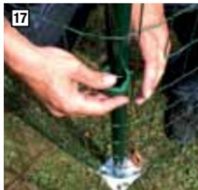
Lassen Sie die Geflechttrolle außen um Ihre Eckpfosten herumlaufen und befestigen Sie es mit Fix-Clip pro® an Pfosten und Streben. Sie brauchen an Ecken das Geflecht nicht zu zerschneiden!
