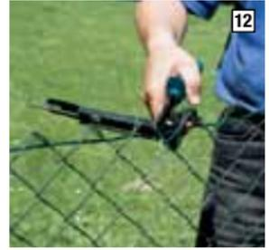
Sollten Sie die Drahtbefestigungszange nicht zur Hand haben, befestigen Sie den Maschendraht mit kurzen Stücken Bindedraht (Art.-Nr. 089707) am Spanndraht.
