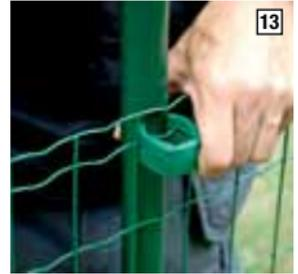
... und anschließend auf der Gegenseite mit der Spannfeder fixieren.
