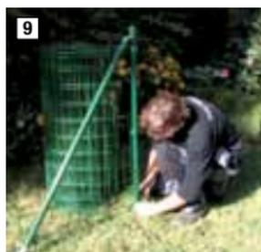
Befestigen Sie das Schweißgeflecht am abgestreikten Anfangs- oder Torpfosten mit 3 Fix-Clip pro® Schellen. Einfach den Clip über das Geflecht stecken und an den Pfosten clipsen. Anschließend auf der Gegenseite mit der Spannfeder fixieren.
