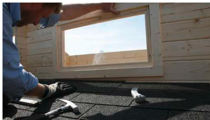
Die folgenden Reihen werden überlappend aufgelegt. Achtung: Auf einer Bahnlänge sollten etwa 4 Dachpappstifte verwendet werden. Diese immer oberhalb des glänzenden Klebestreifens setzen. So werden die Nagelköpfe immer von der nächsten Schindel verdeckt.
