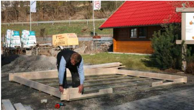
Mit Hilfe eines Assistenten prüfen Sie nun das „Kreuzmaß“. Mit einem Maßband messen Sie die Entfernung der gegenüberliegenden Ecken. Wenn die Maße gleich sind, steht das Haus exakt im rechten Winkel.
