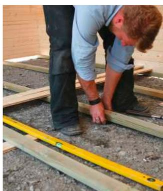
Nun kann der Bodenbelag genagelt oder verschraubt werden. Im Bereich des Türrdurchgangs achten Sie auf einen sauberen Anschluss an die Edelstahlschiene, da an dieser Stelle keine Fussleisten vorgesehen sind. Evtl. kann es erforderlich werden, das letzte Brett in der Breite etwas an zu passen.
