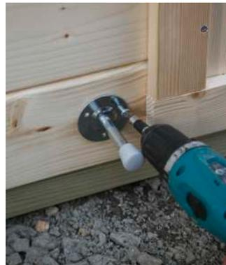
Evtl. kann es erforderlich werden, die Einbohrscharniere am Türblatt durch Ein- oder Ausdrehen etwas nach zu stellen.
