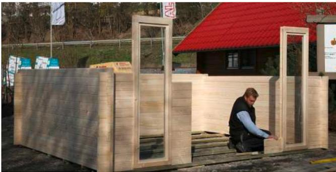
Vor der Montage muß der Stockrahmen der Tür zusammengesetzt werden. Legen Sie die entsprechenden Teile auf einem ebenen Untergrund aus, stecken Sie ihn zusammen und verschrauben Sie die Eckverbindungen. Ein Unterlegen von Holzresten vermeidet Verschmutzungen und Schrammen im Holz.
