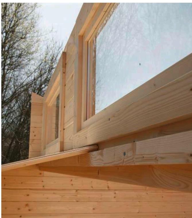
Nun wird das Dach vollflächig vernagelt, bzw. verschraubt. Achten Sie hierbei auf einen geraden Verlauf an den äusseren Dachkanten, damit Sie im nächsten Schritt die Leisten sauber anbringen können.
