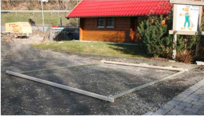
An mehreren Stellen können die Bohlen mit den Bodenbalken verschraubt werden. Auch im Durchgangsbereich sollte vor Kopf eine Schraube sitzen. Die Vorder- und Rückwand liegt nicht vollflächig auf den Balken auf, sondern ragt ca. 3-4mm über die Bodenbalken hinaus. So kann das Wasser abtropfen.
