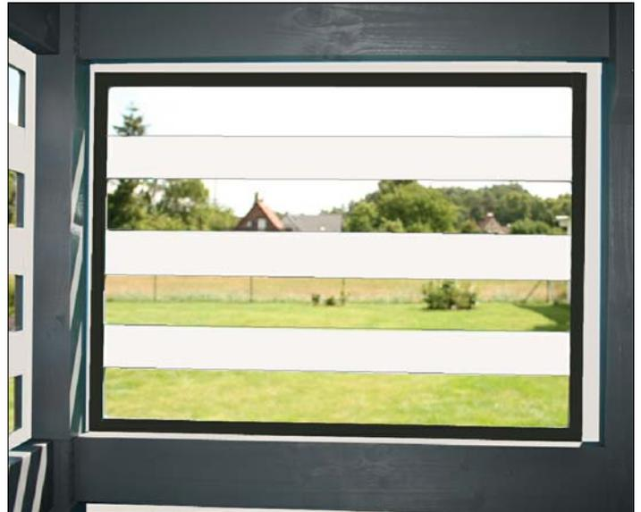
Bringen Sie nun das EPDM Dichtband A109 als Abdichtung von innen als seitlichen Streifen an den Fensterfassadenplatten an. (Beginnen Sie direkt im Anschluß an die Öffnungen). Danach kleben Sie die fehlenden Streifen oben und unten passgenau ein.
