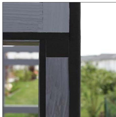
Kleben Sie das Dichtband genau auf Stoß um das Eindringen von Feuchtigkeit zu verhindern! Lassen Sie die senkrechten Dichtbandstreifen durchgehen und kleben Sie im Anschluss die waagerechten Streifen passgenau dazwischen. Halten Sie oben einen Abstand von 0,5cm bis zur Kante!
