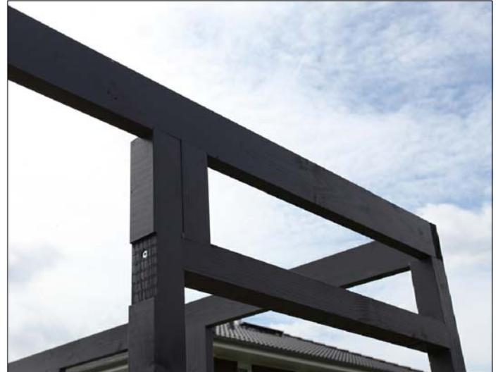
Legen Sie die das waagerechte Kantholz für den Türsturz in die dafür vorgesehenen Aussparungen und achten Sie darauf die Bauteile an den Außenkanten bündig zu setzen. Bohren Sie vor und verschrauben mit 2x C105-0100 jeweils von aussen durch die Pfosten. Halten Sie beim Schrauben ca.4cm Abstand von der Außenkante.
