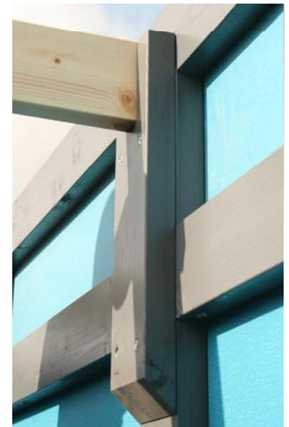
Legen Sie die Pfette in die Aussparungen der Pfettenschuhe und verschrauben Sie die Pfette nach dem Vorbohren mit je 1x C105-0080 von innen durch den Pfettenschuh.
