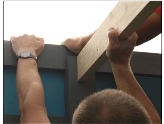
Um die genaue Lage der Pfette und der Pfettenschuhe zu ermitteln, legen Sie ein Dachbrett hochkant vom Auflager vorne bis über die hintere Rähm. Zeichnen Sie dann die Oberkante der Pfette an und ermitteln so genaue Lage der Pfettenschuhe.
