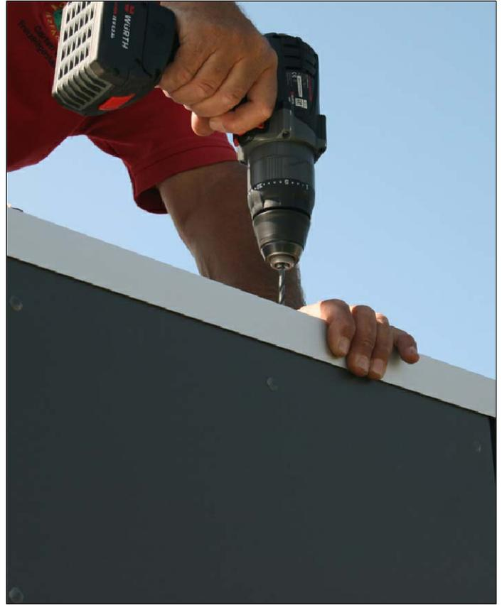
Verschrauben Sie die Aluminiumschienen (A100-220) nach dem Vorbohren mit 6x C104-0045 an der Dachkante mit der Rähm. Lassen Sie die Längsstöße der Aluminiumschienen 2cm überlappen
