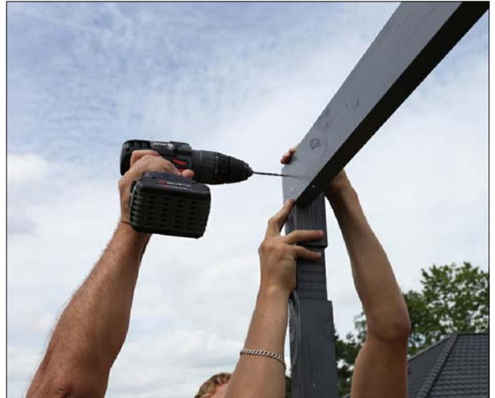
Positionieren Sie die Rähm in der Aussparung am hinteren Teil des Gerüsts, bohren Sie vor und verschrauben Sie diese mit 2x C105-0050 und einem Abstand von 4cm von der Außenkante am Eckpfosten. Bitte beachten Sie die Abstandsvorgaben für das Einbringen der Schrauben, um die Kollision miteinander bzw. mit den Fassadenschrauben zu verhindern.
