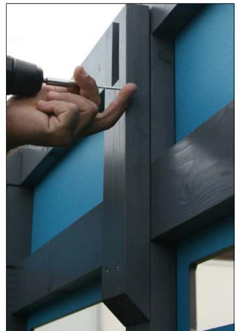
Verschrauben Sie die Pfettenschuhe nach dem Vorbohren mit jeweils 4x C105-0060 von innen an den Mittelpfosten.
