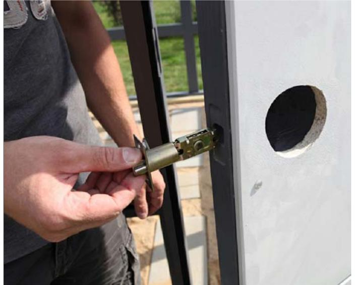
Montieren Sie nun das Türschloss. Erst schieben Sie die Falle in die im Türblatt dafür vorgesehene Stelle und verschrauben diese dann mit den beiden dem Schloss beiliegenden Schrauben. Achten Sie auf die Ausrichtung der Falle!
