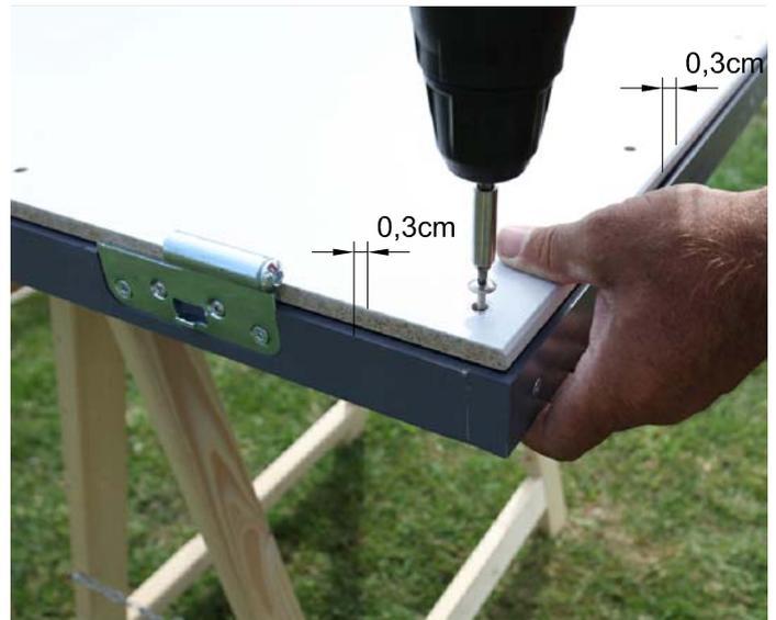
Nun schrauben Sie die oberste Fassadenplatte mit der gleichfarbigen Schraube auf den Türrahmen auf, achten Sie dabei darauf den rechten Winkel zu bleiben und schrauben Sie ganz gerade ein.
