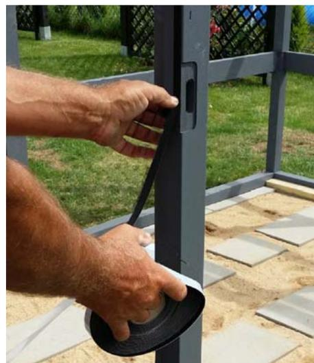
Bekleben Sie das Grundgerüst mit dem EPDM Dichtband A109 (9mm breit) und A111 (30mm breit). Verwenden Sie für die Bereiche in denen 2 Platten aneinander stoßen A111 und für die Ober- und Unterseite des Gerüsts A109. Das Dichtband muss ohne Abstand dicht auf Stoß geklebt werden um eindringendes Wasser zu verhindern. In den Eckbereichen kleben Sie das Dichtband zu gleichen Teilen um die Ecke. Halten Sie oben einen Abstand von 0,5cm bis zur Kante!
