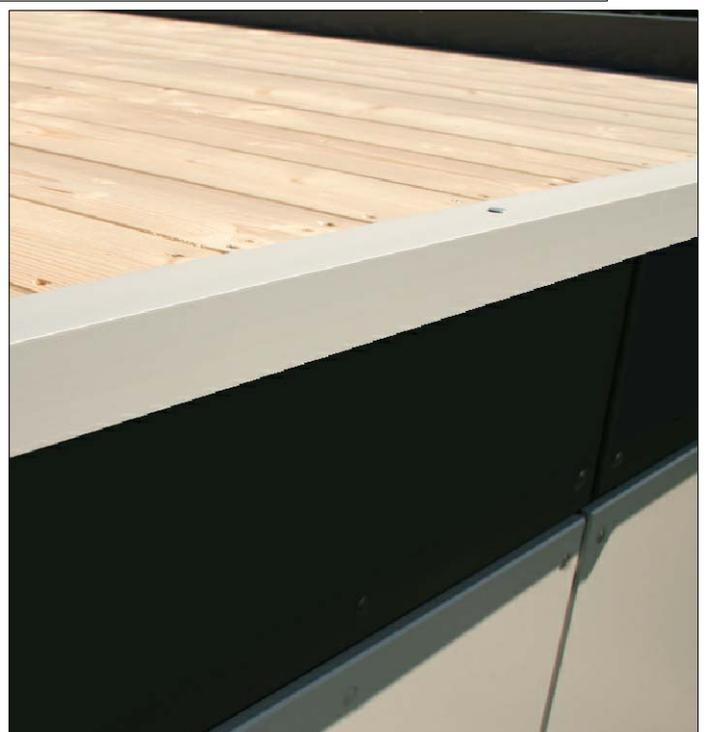
Befestigen Sie nun die Aluminiumschiene A100-220 (Winkelschiene) mit 10x B510 am Ende der überstehenden Dachschalung. Die Aluminiumschienen werden in der Standardlänge von 220cm geliefert und müssen bauseits angepasst werden. Sie sollten an den Längsstößen 2cm überlappen.
