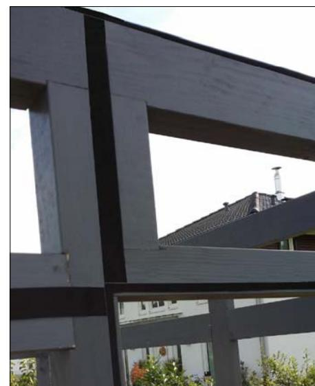
Beginnen Sie mit dem unteren Dichtband (A109) 2cm von der Unterkante des Gebäudes. Kleben Sie das Dichtband generell genau auf Stoß um das Eindringen von Feuchtigkeit zu verhindern!
