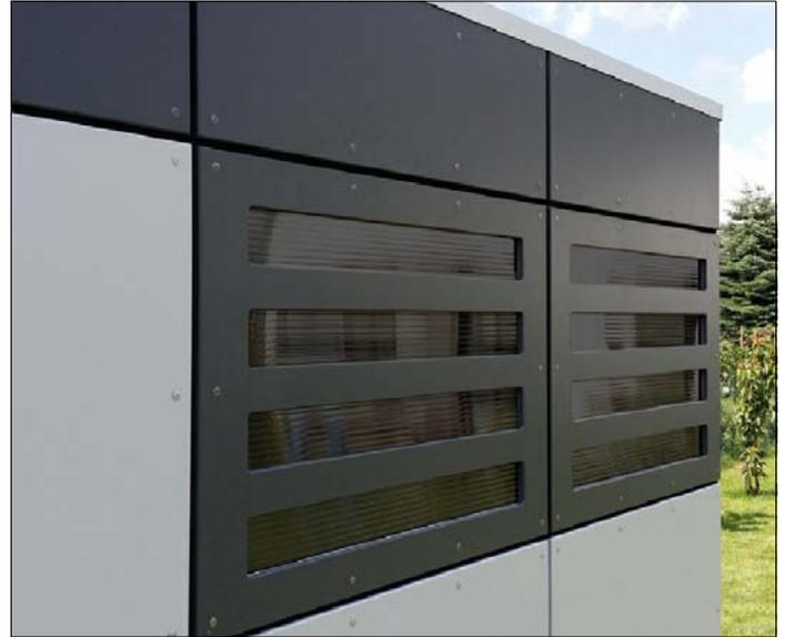
Drücken Sie die Blendleisten beim Anbringen gegen die Platten um die Dichtigkeit gegen das Eindringen von Wasser zu gewährleisten. Sägen sie die Blendleisten passend ab und schrauben nun die seitlichen Blendleisten mit jeweils 3x C105-0030 von innen in den Fensterrahmen. Dann kürzen Sie die waagerechten Blendleisten und verschrauben diese mit jeweils 4x C105-0030 am oberen und unteren Querriegel. (Bohren Sie mit 3mm vor)
