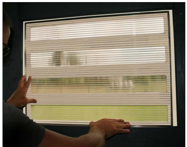
Stellen Sie nun die Doppelstegplatten C200-250 in die entsprechenden Rahmen an das Dichtband und messen die Länge der Blendleisten ab, um diese entsprechend zu kürzen.
