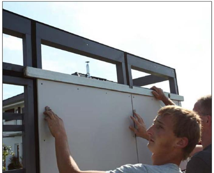
Verschrauben Sie nun die restlichen Fassadenplatten mit ebenfalls 1cm Luft sowohl in der Waage- als auch in der Senkrechten.
