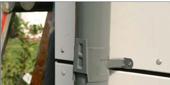
Schneiden Sie das Ablaufrohr (C165-200-01) auf die benötigte Länge zu und stecken Sie dieses mit dem unteren Auslauf (C168-01) zusammen, achten Sie darauf, dass die Naht jeweils nach vorne zeigt. Montieren Sie die untere Rohrschelle über der Steckverbindung zwischen Ablaufrohr und Auslauf mit je 2 Schrauben. Drücken Sie die Rohrschelle zusammen und schieben Sie den Klemmkeil (z.B. mit einem Holzstück) darüber.
