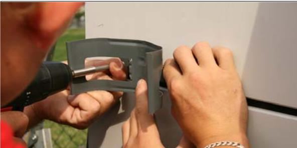
Montieren Sie die obere Rohrschelle (C169-01) mit je 2 Schrauben.
