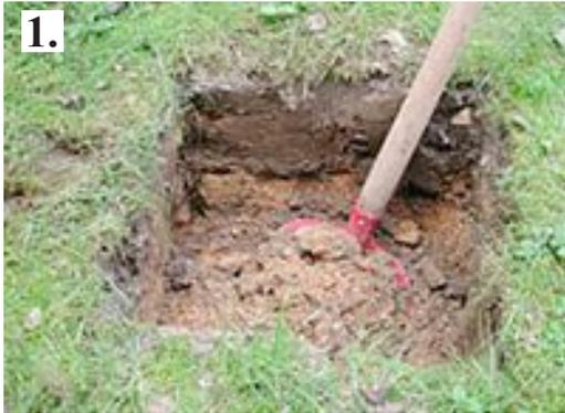
1. Eine Grube für jeden Pfosten ausheben.
