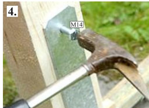
4. Eine Maschinenschraube vorsichtig durch die Öffnung des H-Pfostenankers einschlagen bis sie auf der anderen Seite wieder austritt.
