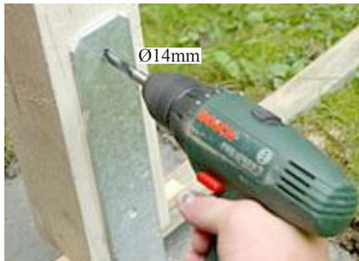
3. Das Holzprodukt aufstellen. Die Pfosten in die H-Pfostenanker stellen. Etwas Abstand zwischen Pfostenende und Metall lassen. Die Pfosten durchbohren um sie mit den H-Pfostenankern zu verschrauben.
