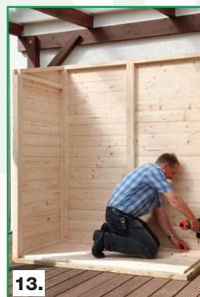
4. Zweite Seitenwand ansetzen und in gleicher Weise am Boden und der Rückwand verbinden. Obere schräge Türleiste zwischen den Seitenwänden einsetzen und von aussen verschrauben. (Abb. 14 - 18)
