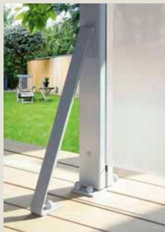
Beim Einsatz auf einem „wind- und sturmoffenen“ Gelände, zum Beispiel auf einer an ein freies Feld grenzenden Terrasse oder in Küstennähe, muss die SYSTEM Anlage zusätzlich zu der normalen Befestigungen am Boden gesichert werden. Die Glaselemente halten dem Winddruck stand. Der Winddruck überträgt sich jedoch auf die Pfosten und die Bodenanker. Ab einer höheren Windstärke kann sich die Pfostenbasis verbiegen.
