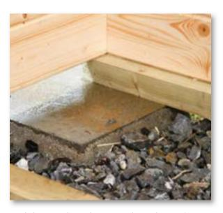
**Verdichtetes Schotterbett mit Gehwegplatten** als Minimaluntergrund für die Errichtung eines Hauses.
