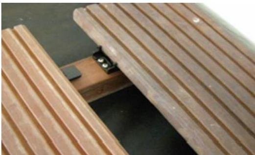
Nachdem die Clipper festgeschraubt sind, drehen Sie die Diele um und schieben die Endstücke der Clipper (Stifte) in die Einführungsöffnungen der Clipper des bereits fixierten Brettes. Durch die jeweils noch 2 sichtbaren Bohrlöcher werden die Clipper an die Unterkonstruktion geschraubt.
