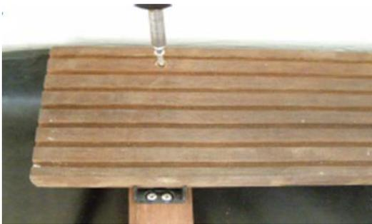
Um einen sicheren Halt zu gewährleisten, verschrauben Sie die erste Diele zusätzlich, sichtbar mit der Unterkonstruktion. Dieleenden dürfen nicht mehr als 5 cm über die Unterkonstruktion überstehen.
