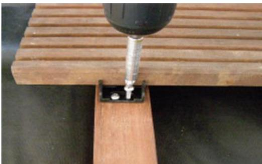
Danach drehen Sie das Brett um und verschrauben es auf der Unterkonstruktion durch die zwei sichtbaren Bohrlöcher. Die Einführungsöffnung muss dabei zur noch zu belegenden Fläche zeigen.
