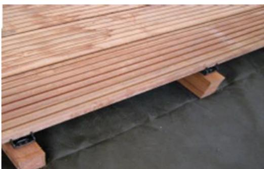
Wiederholen Sie diese Vorgänge, bis Sie die gewünschte Fläche komplett verlegt haben. Gegebenenfalls noch die überstehende Unterkonstruktion abschneiden.
