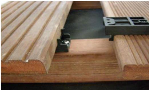
Legen Sie die nächste Diele mit der Oberseite nach unten vor die zuvor montierte Diele, um den Clipper passgenau anzubringen. Die Einführungsöffnung zeigt zu der/ den bereits fixierten Diele(n). Beachten Sie, dass mit dem Clipper ein Fugenabstand von 5 mm vorgegeben wird.
