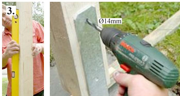
Das Holzprodukt aufstellen. Die Pfosten in die H-Pfostenanker stellen. Etwas Abstand zwischen Pfostenende und Metall lassen. Die Pfosten durchbohren um sie mit den H-Pfostenankern zu verschrauben.
