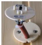
3. Befestigungsplatte mit den mitgelieferten Schrauben anschrauben. Es ist darauf zu achten das die Aufschrift „Top“, auf der Rückseite der Befestigungsplatte, nach oben ausgerichtet ist. Wird die Befestigungsplatte falsch herum montiert, kann angestautes Wasser nicht ablaufen.
