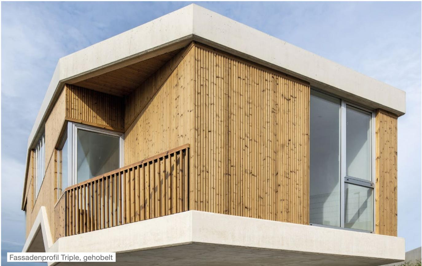
Fassadenprofil Triple, gehobelt
