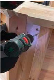
Befestigen Sie die Außenecken mit Schrauben 4.5x70 6-3 St / Schnittstelle
