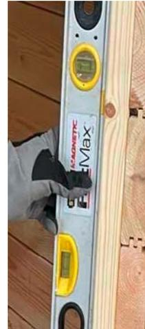
Stellen Sie sicher, dass die Wände vertikal sind und die Diagonalen gleich lang sind
