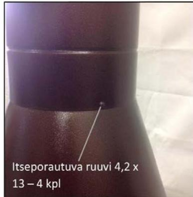
Selbstbohrende Schraube 4,2 x 13 — 4 St.
